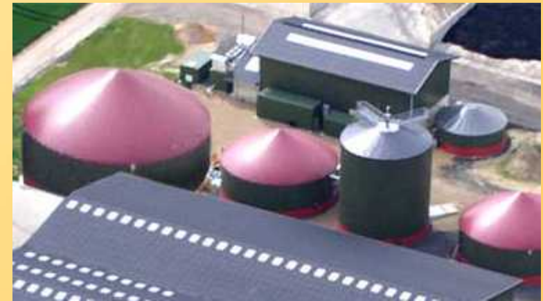
Source: Schornbuscher Biogas GmbH
